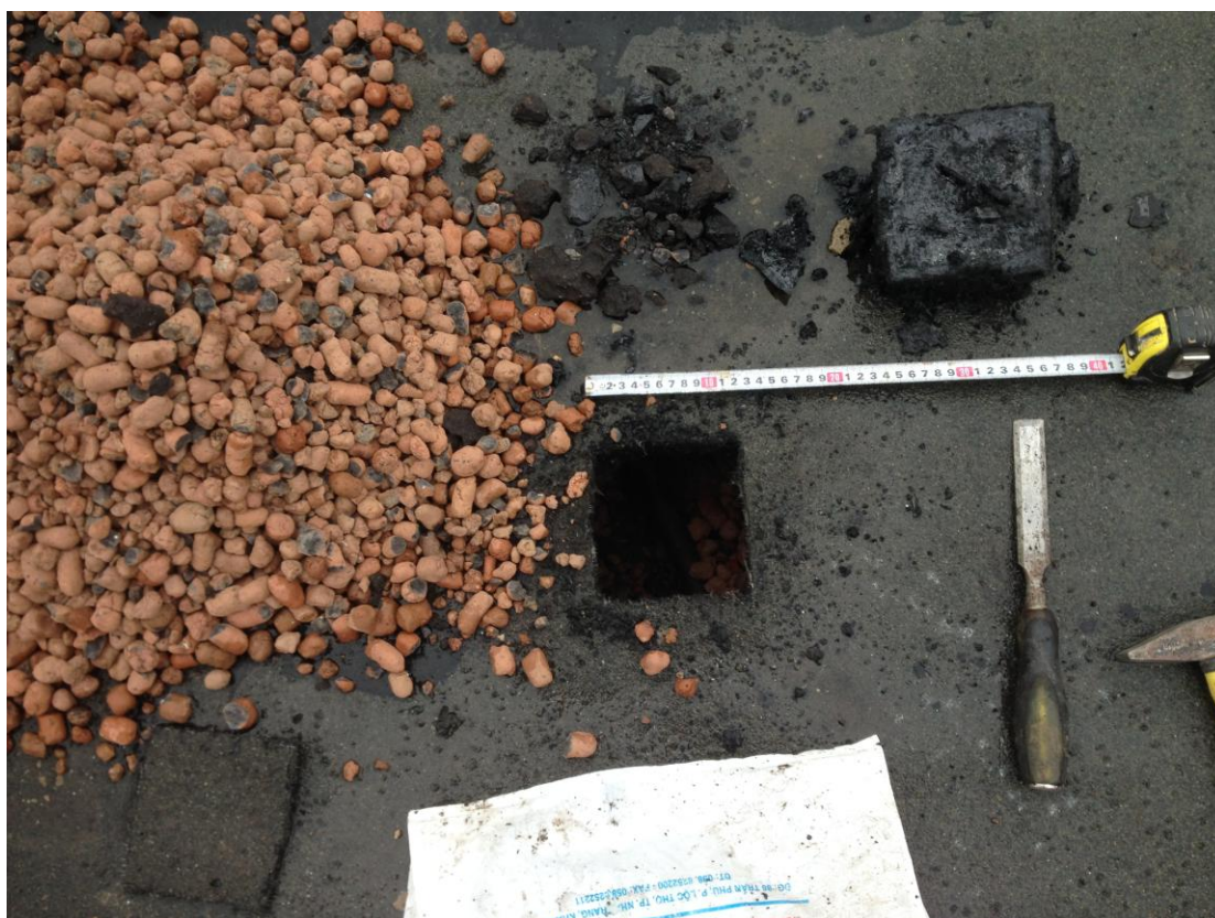
Фото 7 Состав кровли (шурф)
