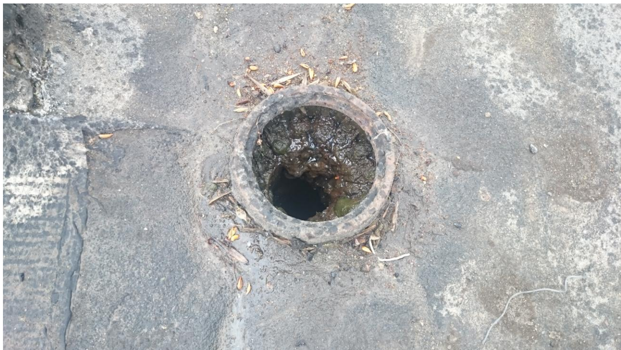
Фото 5 Водосточная воронка
